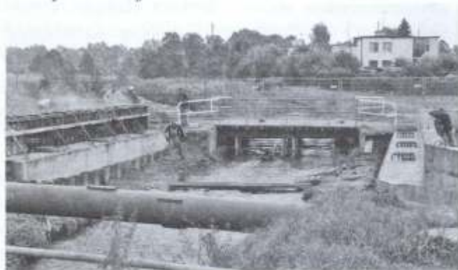
Budowa mostu na Okalicy
